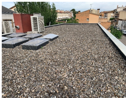
Badalot de ventilació dels banys
